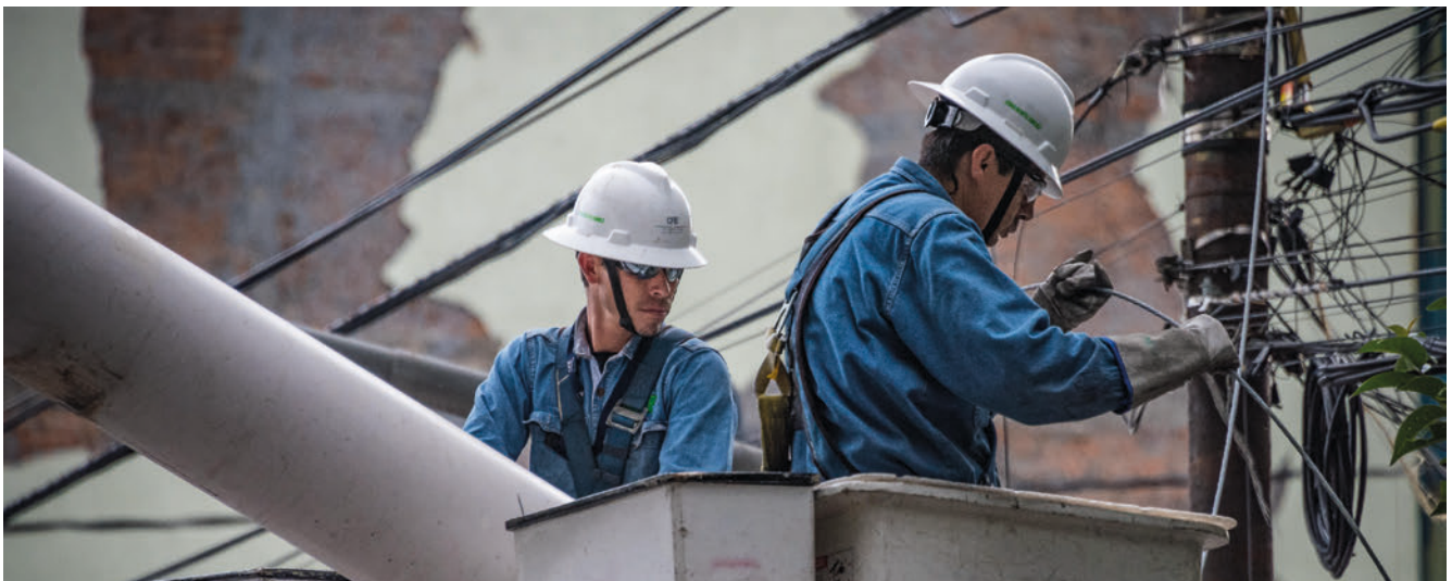
Fotografía 8. Restablecimiento de líneas de transmisión | Comisión Federal de Electricidad
