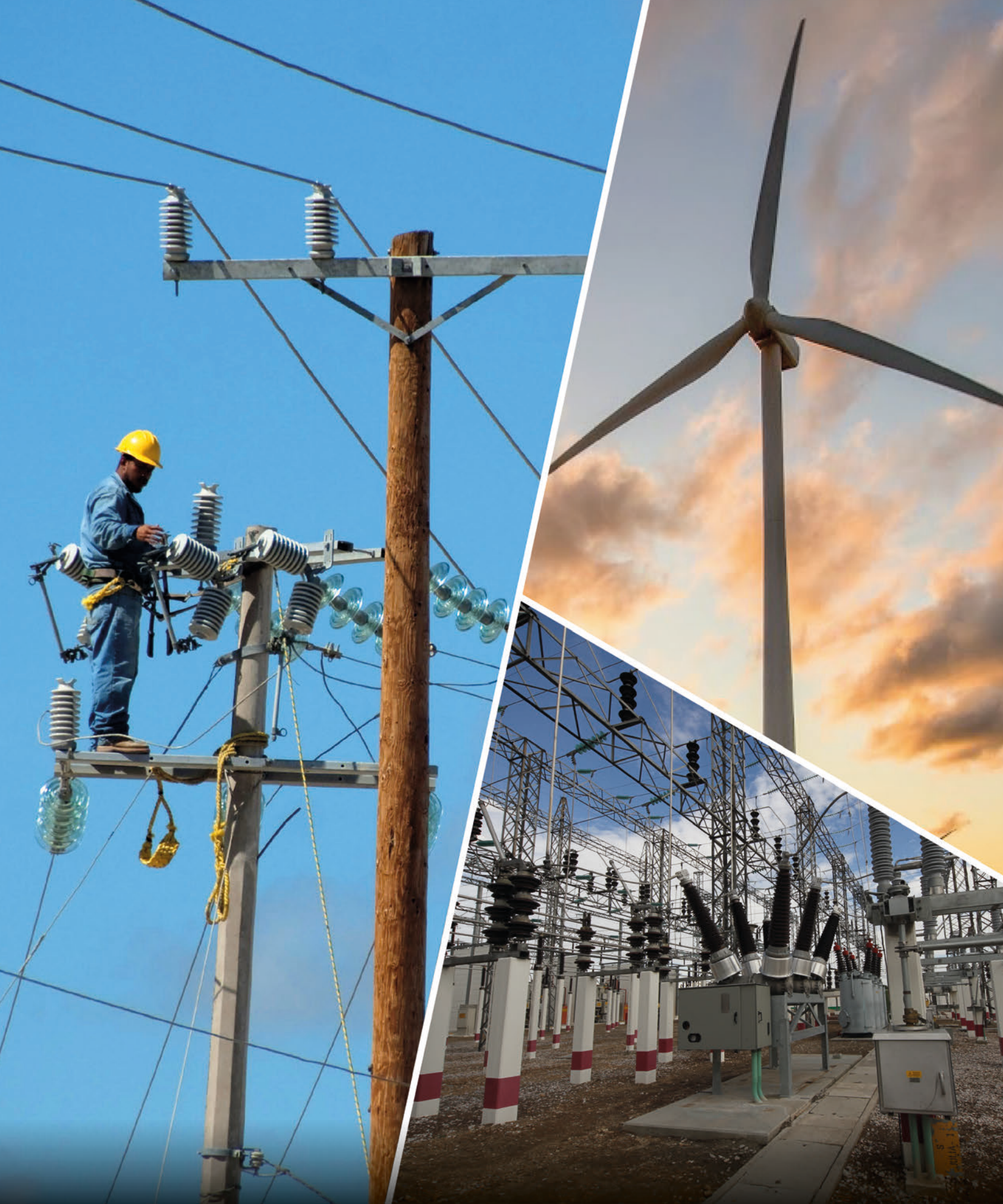
Fotografía 7. Torre de transmisión. Generador eólico. Subestación de Distribución, Saltillo, Coahuila. | Comisión Federal de Electricidad.
