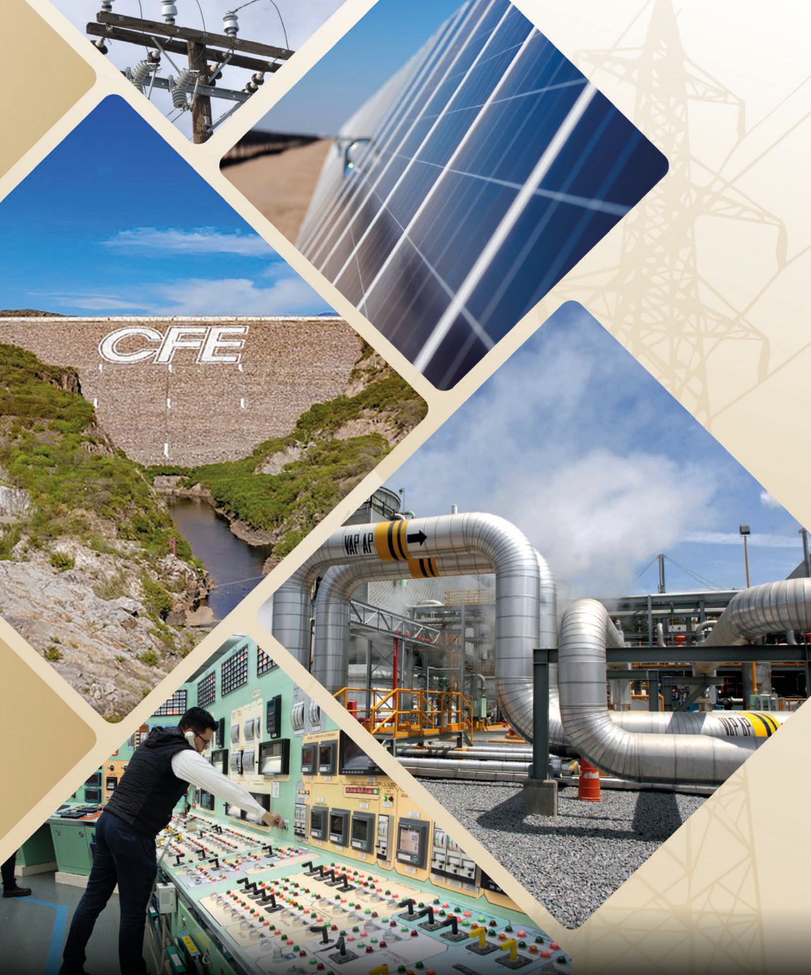
Fotografía 2. Aisladores. Parque Solar Villahermosa, Tabasco. Hidroeléctrica “El Cajón”, Santa María del Oro, Nayarit. 2019. Central Geotérmica “Los Humeros”, Puebla. Central Nucleoeléctrica “Laguna Verde”, Alto Lucero, Veracruz. | Comisión Federal de Electricidad.
